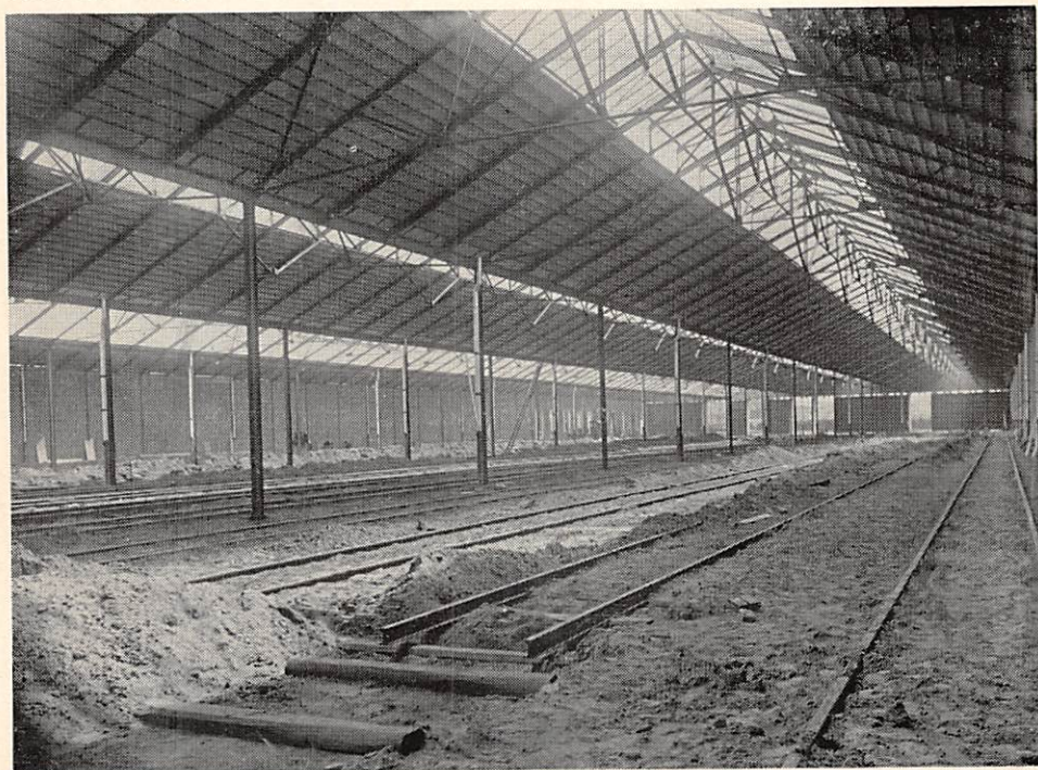
Bouw tramremise Hoboken, Jan Van de Wouwerstraat Maart 1926 (Verzameling E. Keutgens)
